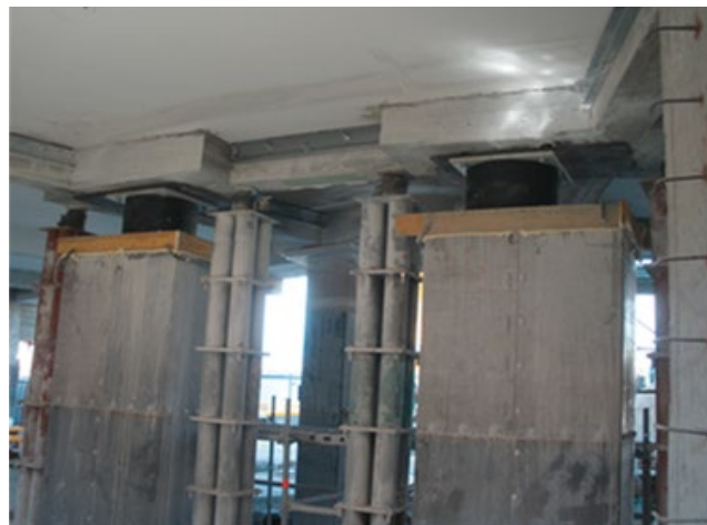
FIGURA 5 Isolatori inseriti, i martinetti sono ancora in opera (Condominio Pianola)
