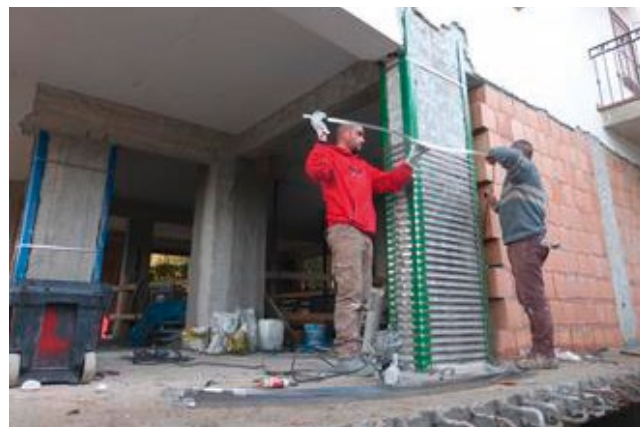
FIGURA 15 Fase di realizzazione del CAM sui pilastri senza giunto (Edificio Bifamiliare)
