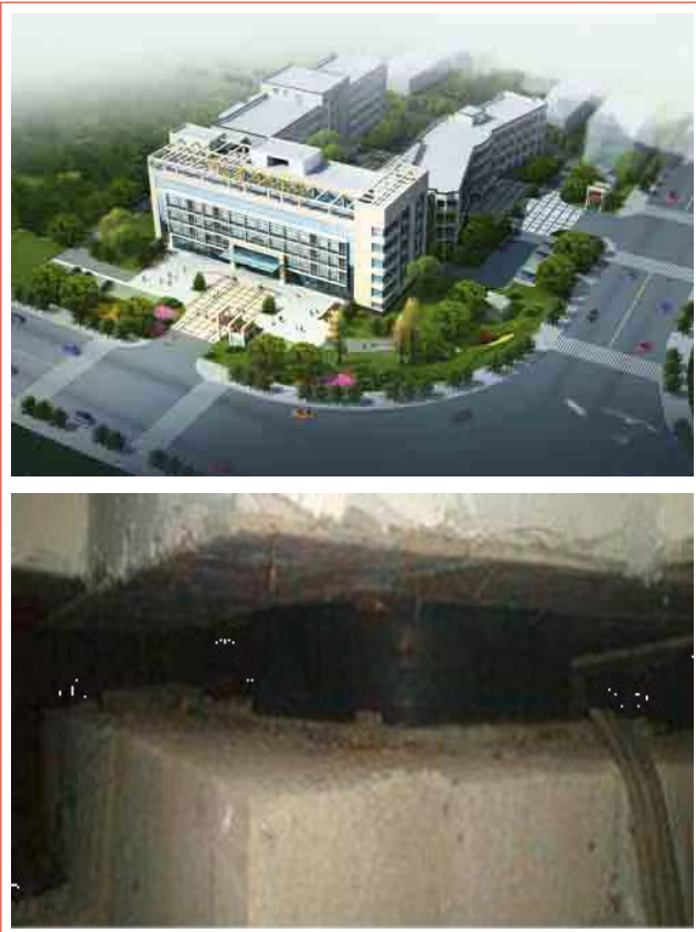
FIGURA 16 Vista (prima del terremoto del 20 aprile 2013) dell'ospedale della contea di Lushan, costituito da un edificio isolato sismicamente (quello frontale, nella foto) e due fondati convenzionalmente (quelli laterali) ed uno degli 83 LRB che costituiscono il sistema d'isolamento dell'edificio isolato Fonte: Zhou et al., 2013; Martelli et al., 2014a
