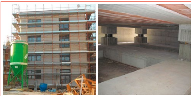
FIGURA 9 Il nuovo edificio B del Liceo Scientifico Romita a Campobasso (ex zona sismica 2), ricostruito con l'isolamento sismico (12 HDRB e 10 SD) dopo la demolizione degli edifici A e B nel 2010 (essi si erano dimostrati insicuri a seguito di prove sui materiali costruttivi effettuate dall'ENEA nel 2003; l'edificio è stato collaudato dallo scrivente nel 2013 Fonte: Martelli et al., 2014a
