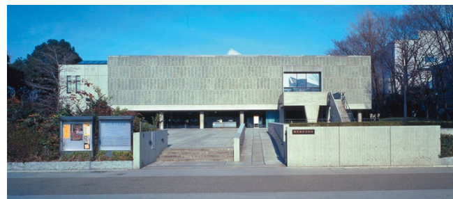
FIGURA 15 Il National Western Art (Le Corbusier) Museum (4 piani) di Tokyo, adeguato con l'inserimento di HDRB in soффondazione nel 1999; durante il terremoto di Tohoku del 2011 l'isolamento ridusse i valori della PGA nelle due direzioni orizzontali da 0,19 e 0,27 g a 0,08 e 0,10 g alla sommità Fonte: JSSI, 2013; Martelli et al., 2014a
