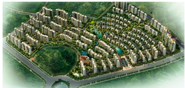
FIGURA 5 Uno dei complessi di edifici residenziali isolati sismicamente nella R.P. Cinese, realizzato nella parte sudoccidentale del paese e costituito da 82 edifici di 4-16 piani tutti isolati singolarmente (area totale = 210.000 m 2 ); molti edifici isolati cinesi sono residenziali e, fra questi, numerosi sono quelli in muratura, anche di notevole altezza Fonte: Martelli et al., 2014a
