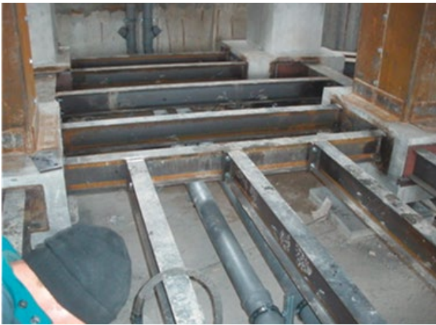
FIGURA 6 Graticcio delle travi in acciaio a collegamento dei pulvini. Si può notare che anche l'impiantistica passa nel vano tecnico ed è ispezionabile (Condominio Pianola)
