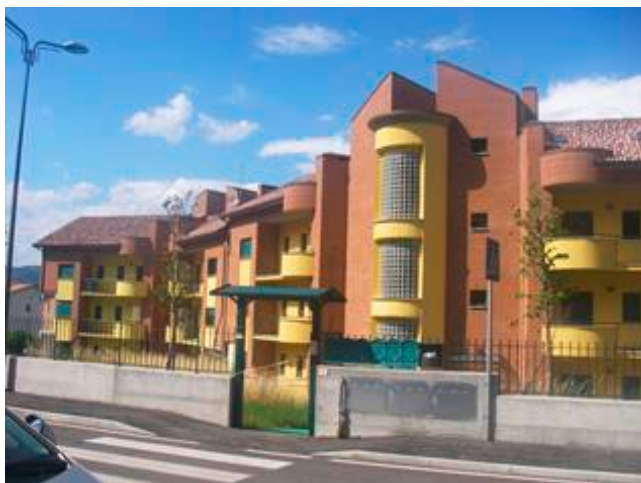
FIGURA 1 Vista d'insieme dell'edificio oggetto di intervento (Condominio Pianola)
