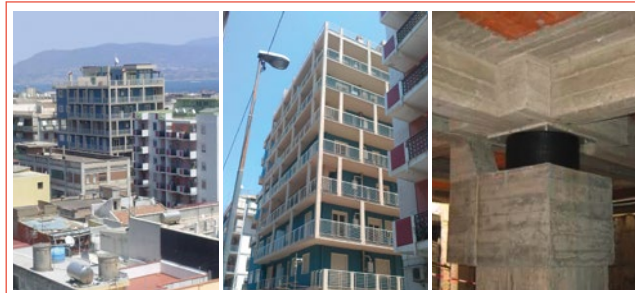
FIGURA 11 Esempio di recente applicazione italiana dell'isolamento sismico a scopo preventivo: il nuovo edificio di 7 piani fuori terra di Via Spadafora a Messina (ex zona sismica 1), protetto da 22 LRB e 2 SD installati alla sommità del cantinato (progetto del sistema d'isolamento dei soci del GLIS Ingg. Manlio Marino ed Alberto Dusi; certificato di collaudo in corso d'opera rilasciato dallo scrivente e dall'Ing. Giovanni Caminiti di Messina a luglio 2014)
