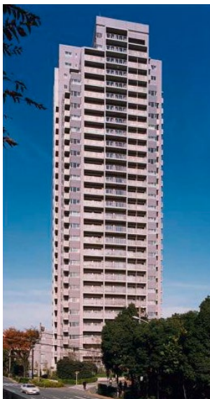
FIGURA 3 Edificio di 87,4 m a Tokyo, isolato nel 2000 con 30 LDRB e 99 dissipatori EPD Fonte: Martelli et al., 2013
